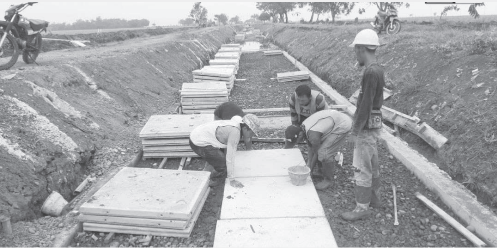
工人在修葺灌溉沟渠网。
