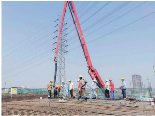
雅万高铁DK9+094连续梁施工现场，中印尼员工正在进行连续梁浇筑。
