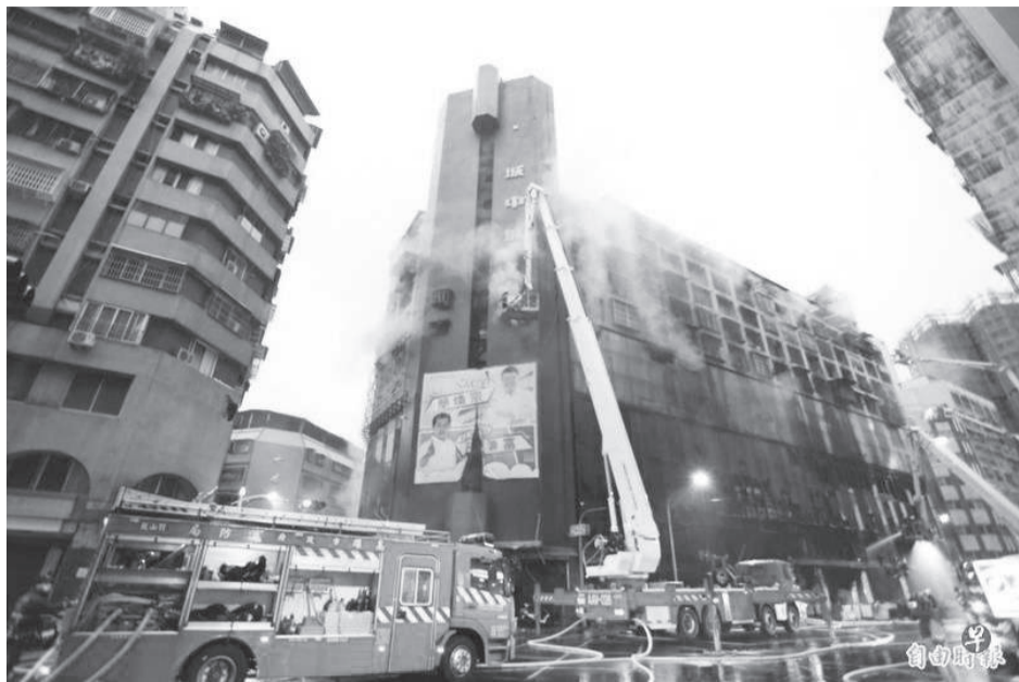
“城中城”大楼有40年历史，是栋地上13层、地下两层住商混合大楼，地下一楼及二楼未使用，地上一楼至五楼废弃中，七楼至11楼约有120户住户。（早报）
