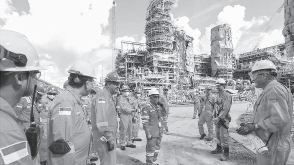
建设中当固3线炼油厂。
