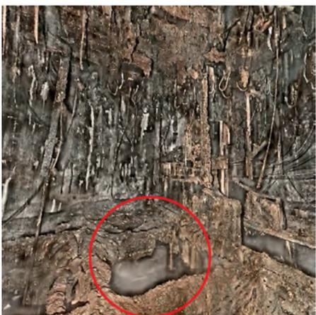
核废炉内部图片：红圈处地板被烧穿。
