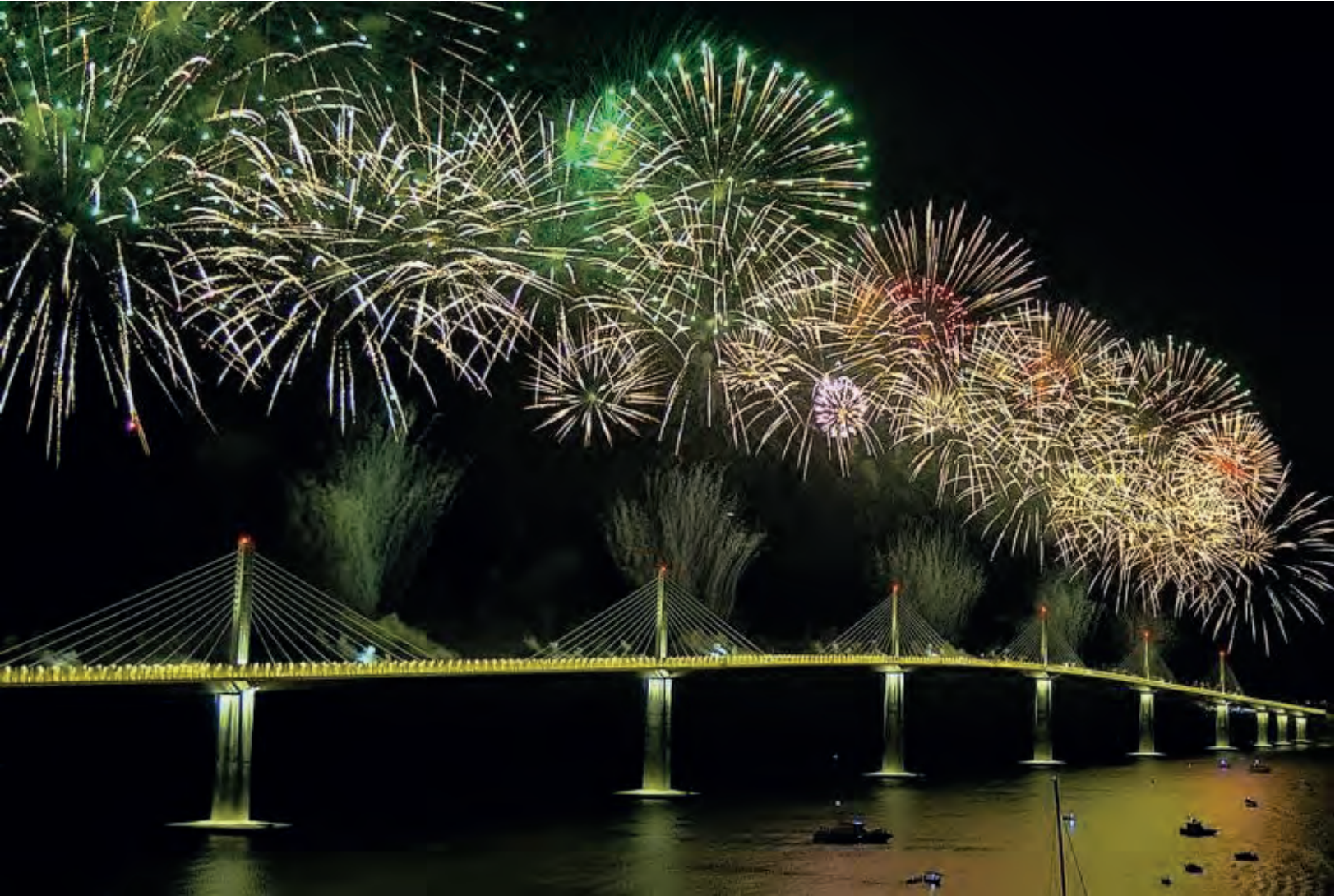
克罗地亚佩列沙茨大桥通车跨越海峡：由中国路桥建设公司牵头，按欧盟规则及获欧盟基金承建（图：新华社）
