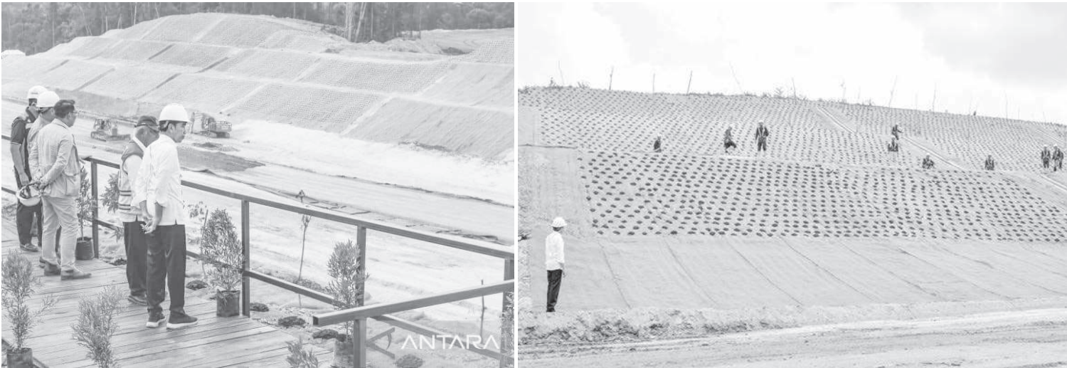
佐科威视察连接麻里巴板和新首都努山打拉的高速公路建设进度。
