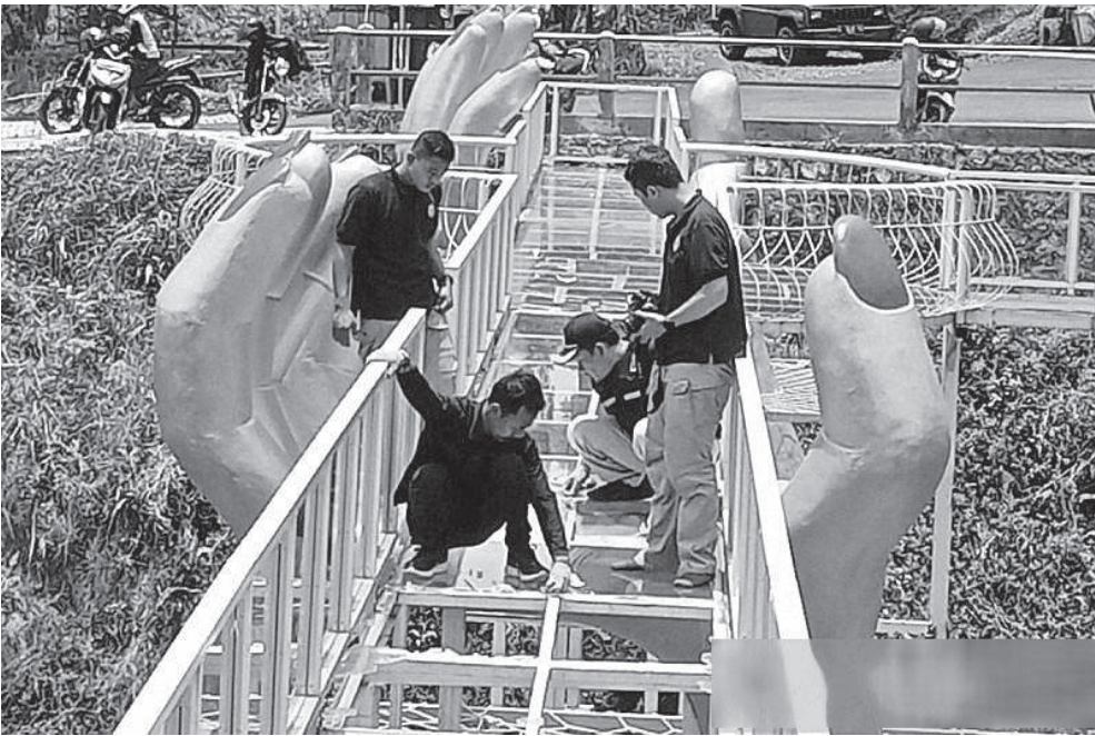
警方对发生破裂的玻璃桥展开调查。
