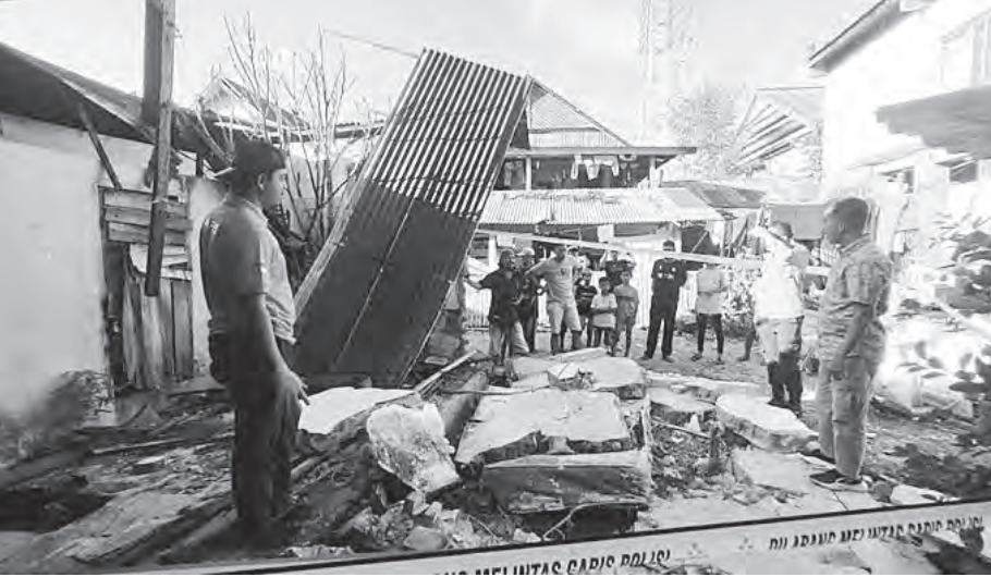
房屋墙壁倒塌造成两名小孩逝世，另一人性命垂危。
