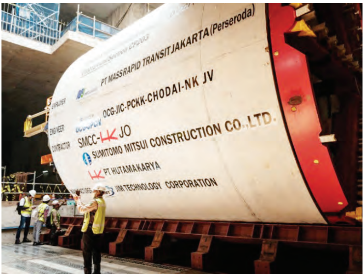
5月7日, 雅加達地鐵第二期專案安裝了隧道掘進機。
