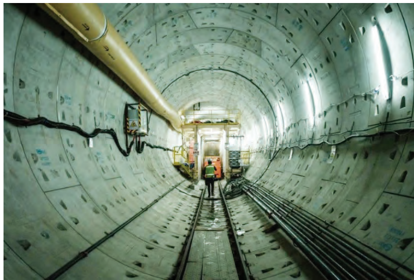
建築工人本月7日檢查南北線第2階段地下隧道。
