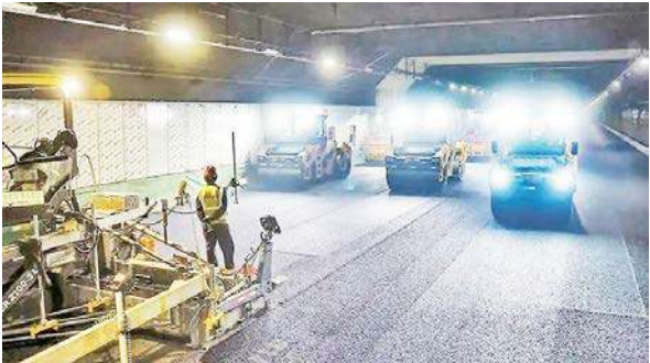
深中通道开始隧道沥青路面施工：五月中旬已完成。
