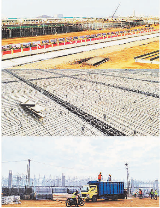
中印尼两国双园巴塘产业园施工现场。
