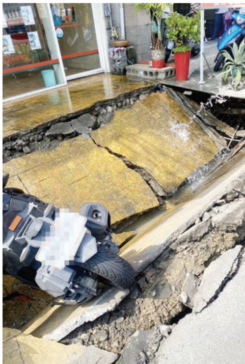
面性盘查，对水利沟渠里面做加固植钢筋，再编列预算，将该路段建置人行道。
