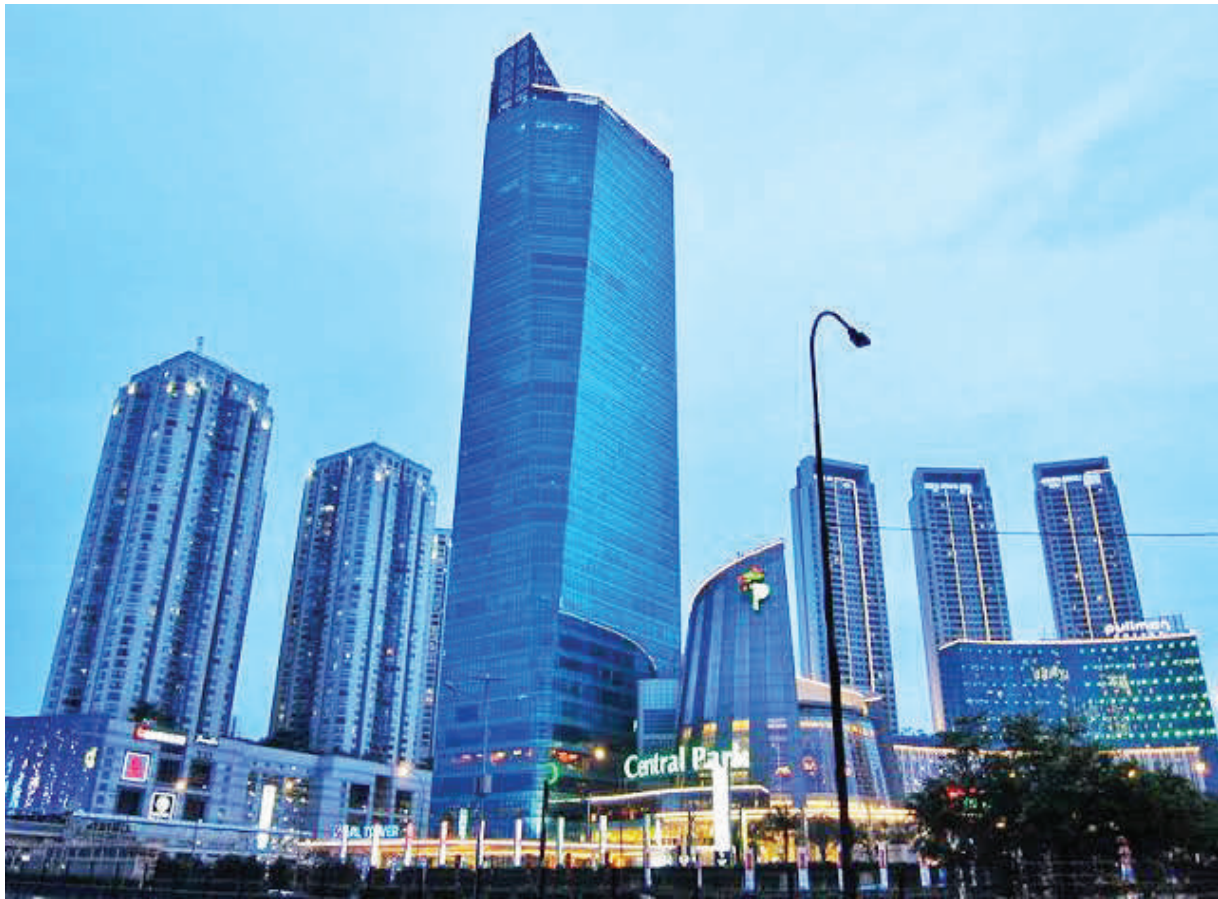
燕潮物流印尼办公大楼。
