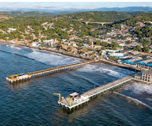
中方援建的萨尔瓦多拉利伯塔德新码头：中方首个援萨成套项目，涵盖码头设施及商业、公共卫生和景观区建设。（图：新华社）
