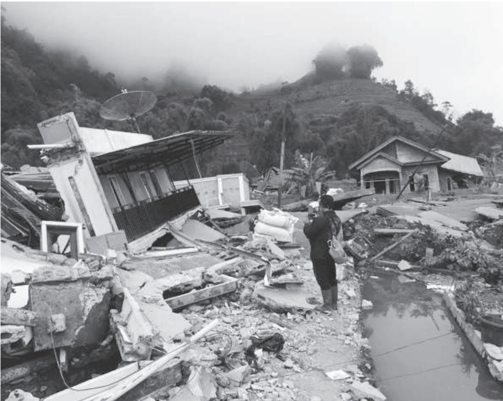
不少房屋及道路遭受损坏。
