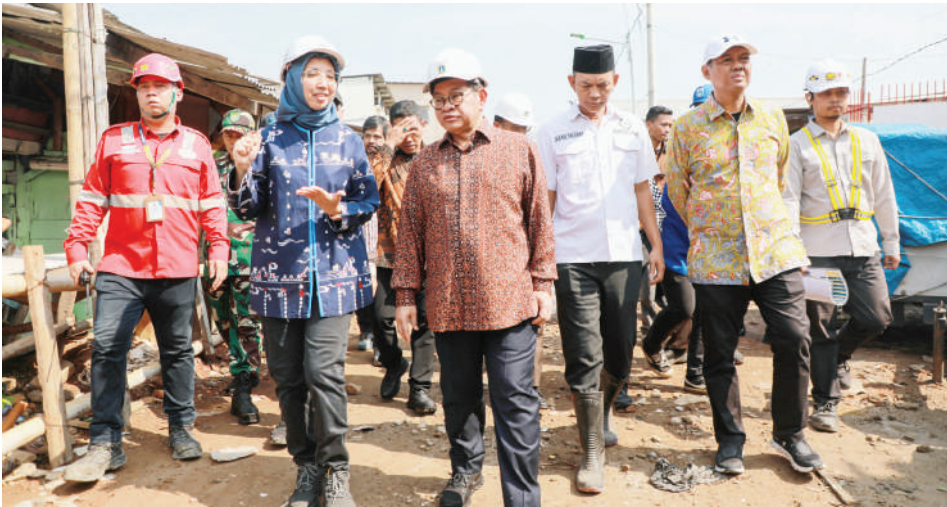
雅加达省长普拉莫诺（左三）视察穆瓦拉昂科防洪堤坝的建设过程。
