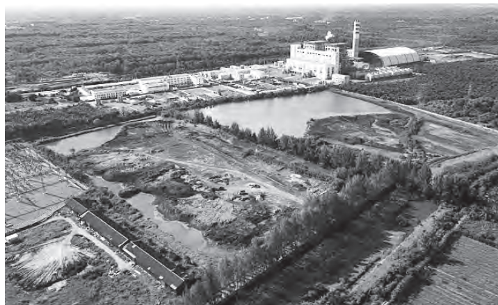
印尼亚齐省西岸的一个燃煤发电厂。
