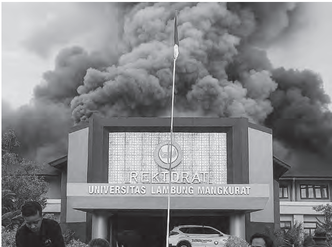
马辰的兰锋.曼库拉特大学校长办公大楼发生火灾。
