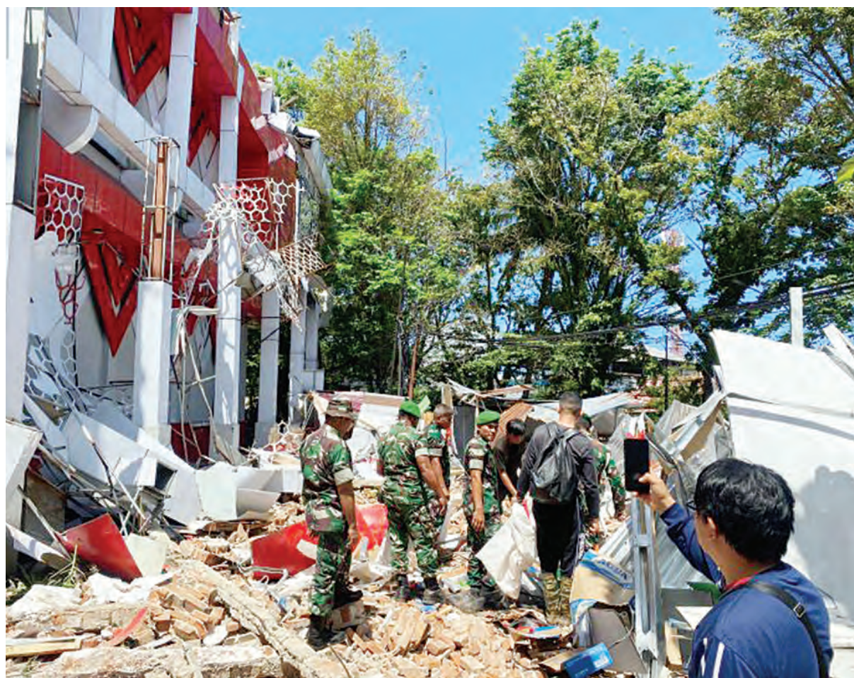
地震造成不少建筑物损坏。
