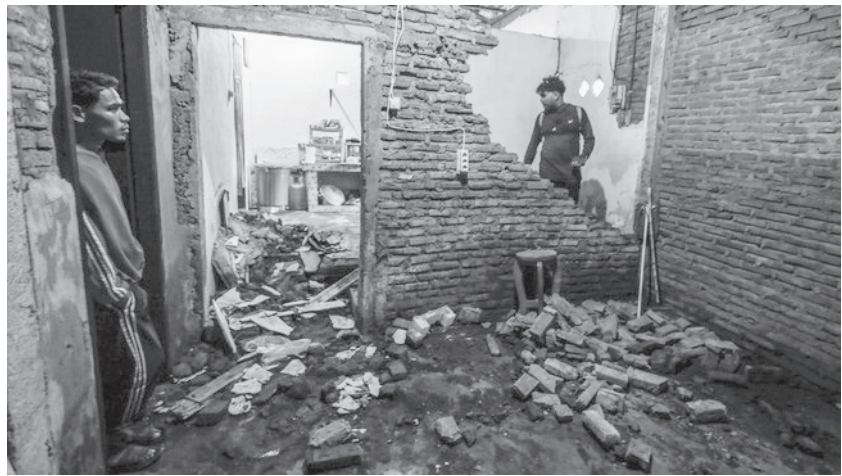
北苏拉威西省多个地区的房屋和建筑物遭到严重损坏。
