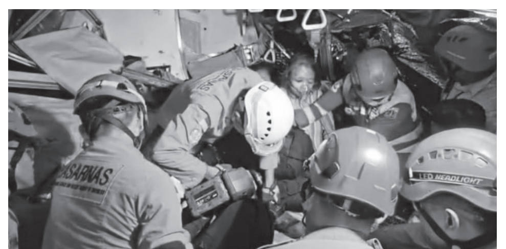
救援人员使用液压设备,尝试切割变形的钢铁结构。
