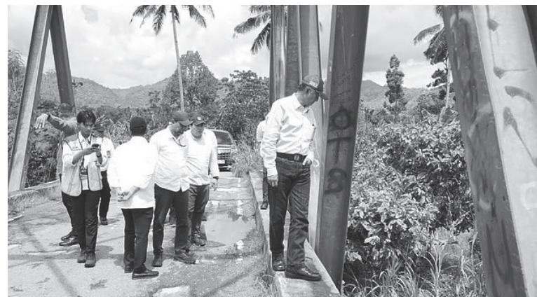
工程部长多迪（右）检查桥梁。
