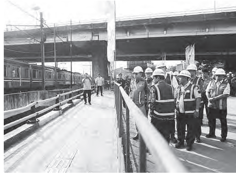
普拉莫诺视察拉图梅滕高架桥项目建设进度。
