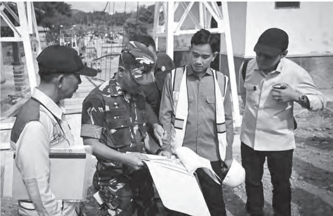
吉布兰视察肯达维悬索桥建设。
