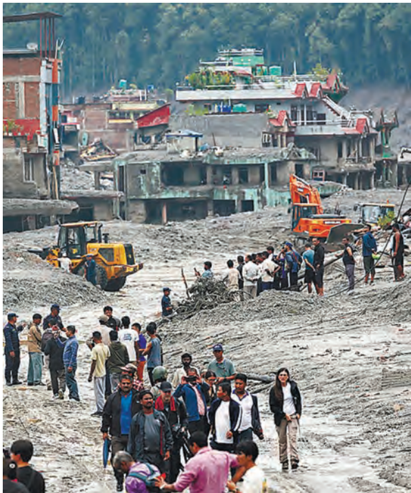
受灾地区：灾後开始进行基础设施修复。（图：欧新社）
