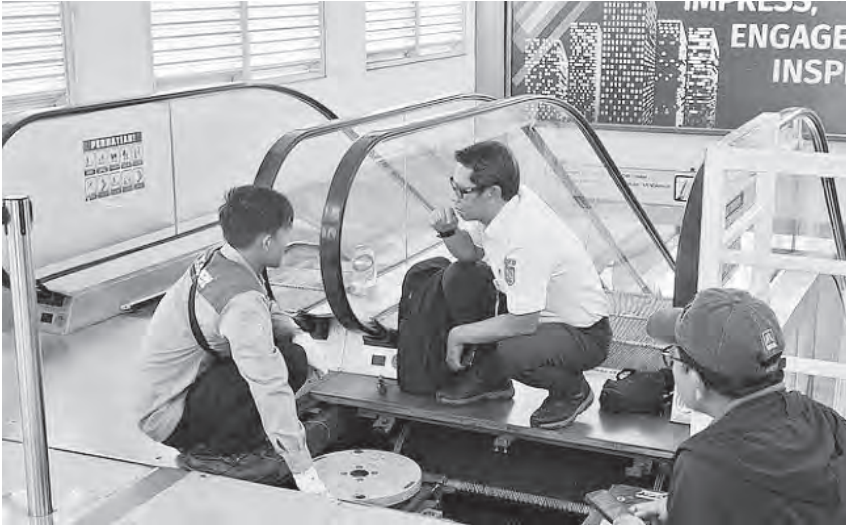
工作人员检查自动扶梯及进行维修。
