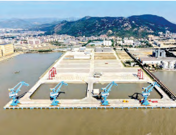
福州港元洪作业区1号、2号泊位工程竣工。
