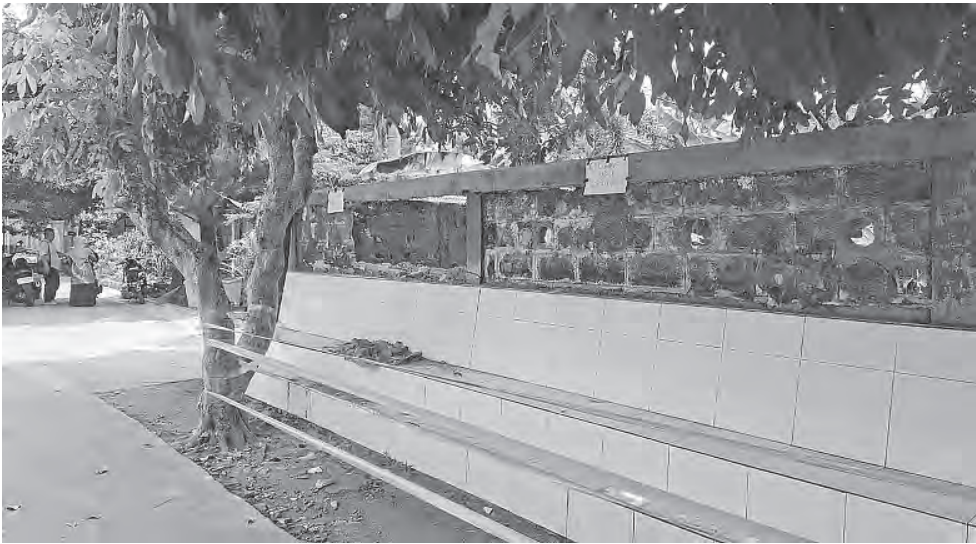
倒塌围墙被系上警戒线。
